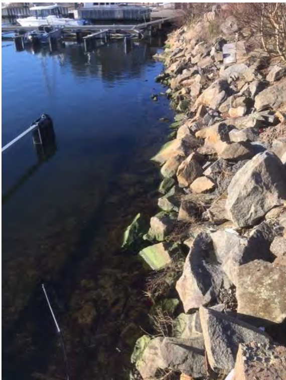
Bild 3. Befintlig strandlinje med sprängsten
