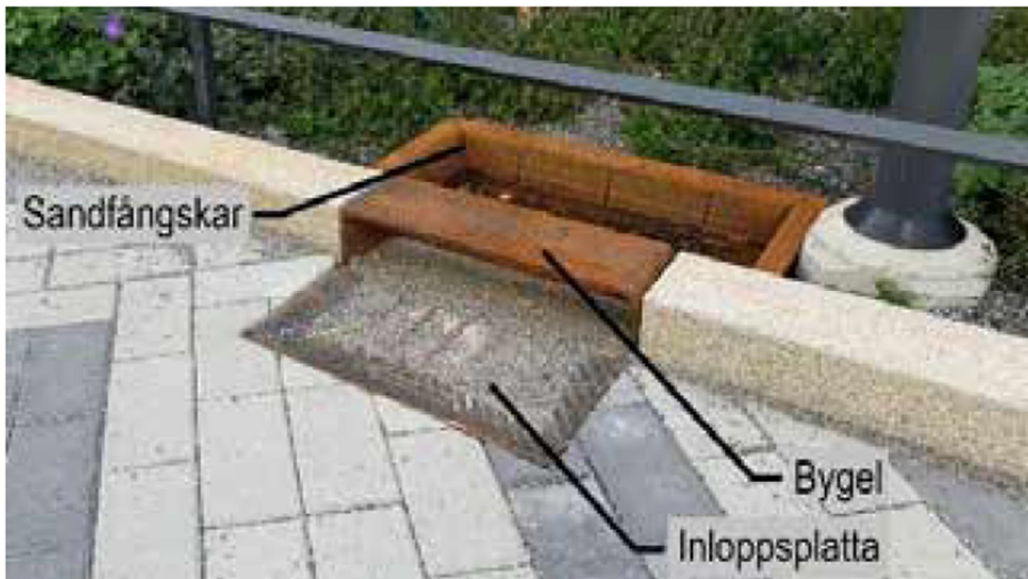
Figur 16. Principlösning för inlopp till regnbäddar. 2
