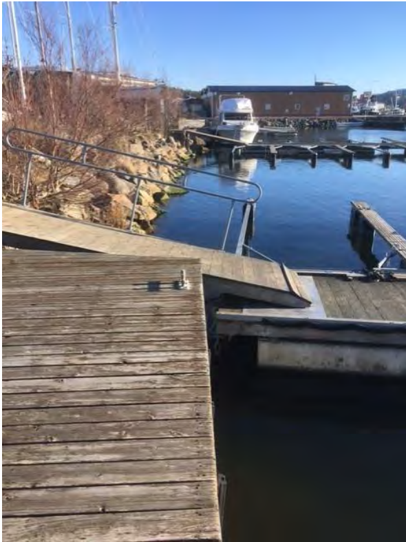
Bild 1. Befintlig konstruktion och hängbrygga
