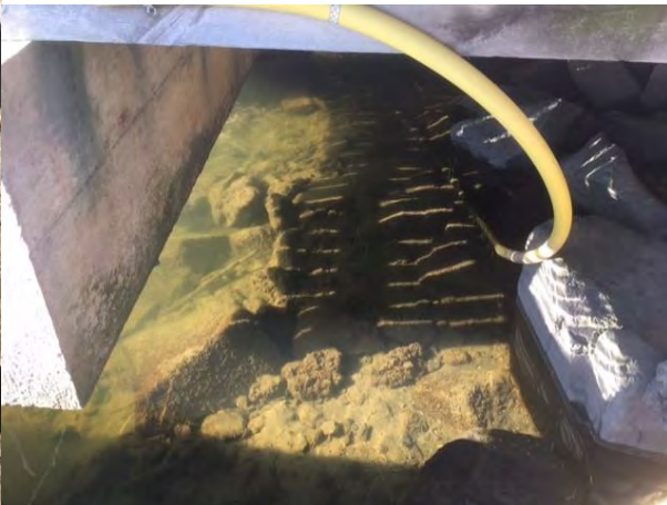
4. Befintlig konstruktion och sprängsten
